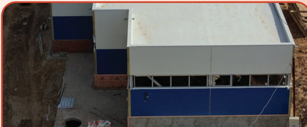
Производственно-складской комплекс ООО «САНГРИ ПОЛИГРАФСЕРВИС». Устройство кровли с применением ПВХ-мембраны Sikarplan. Одинцово, 10 000 м 2 , 2014 г.
