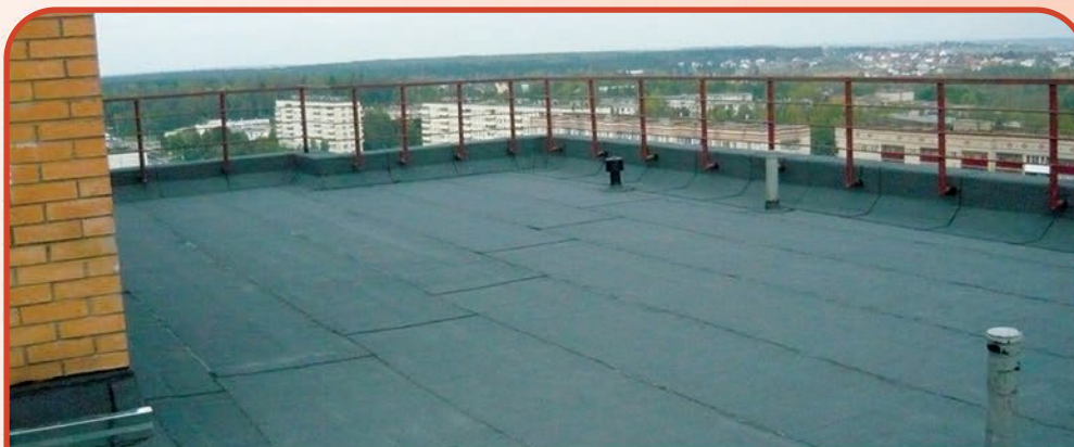
Устройство кровельного пирога, жилой дом , г. Солнечногорск, 990 м 2 , 2012 г.
