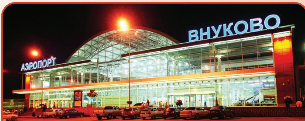
ОАО «ВНУКОВО». Устройство кровли с применением мембраны Logicroof, 14 000 м 2 , 2013 - 2014 гг.
