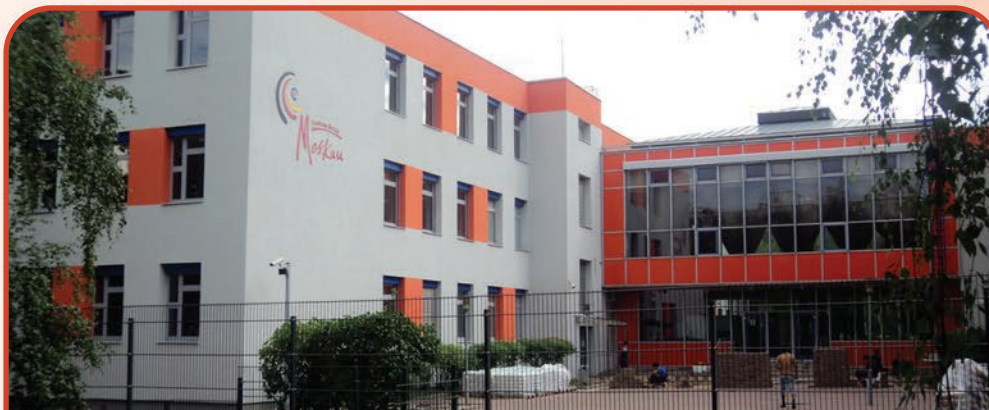
Немецкая школа им. Ф. П. Газа при посольстве Федеративной Республики Германии. Ремонт кровли с применением материала Техноэласт. г. Москва, 1 000 м 2 , 2013 г.
