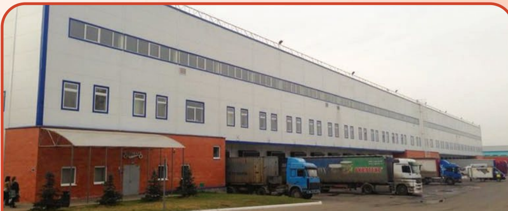
Устройство кровли здания складского корпуса К-9 из профлиста ООО «Логистический парк «Томилино», площадь 14 000 м 2 , Московская область, Люберецкий район, п. Томилино, мкр. Птицефабрика, строение лит. А, А1, 2012 г.
