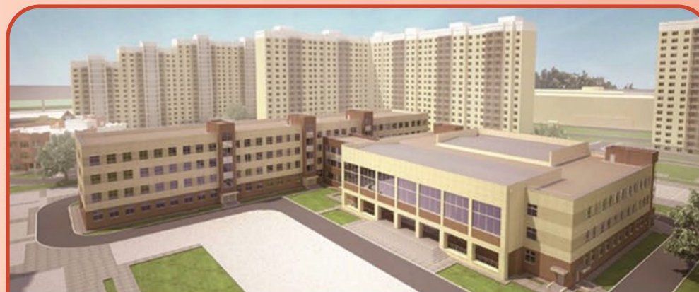
Школа начального и среднего образования на 1100 учащихся. Устройство кровли с применением материалов Техноэласт и ПВХ-мембраны Logicroof. г. Москва, Новые Ватушки, 5 600 м 2 , 2014 г.
