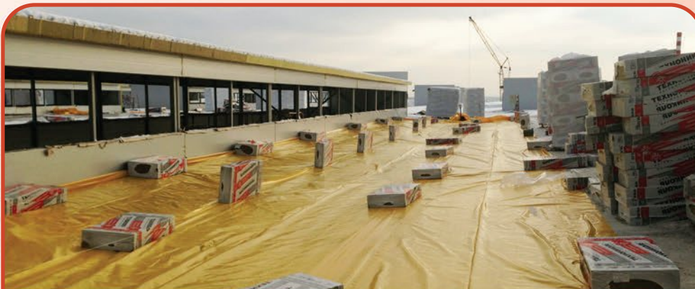
Комплексный монтаж кровли с применением битумно-полимерной гидроизоляции производственно-административного здания «Стильные кухни» площадью 24 000 м 2 , г. Щелково, 2014 г.
