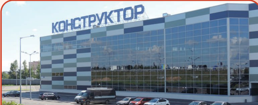
Комплексный монтаж кровли с применением ПВХ мембраны, ТЦ «Конструктор», площадь 5 600 м 2 , МКАД, 25-й км, 2013 г.
