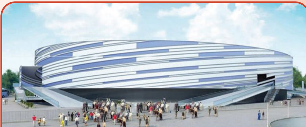
Комплексный монтаж кровли с применением ПВХ мембраны и битумно-полимерной гидроизоляции на « Малой ледовой арене для хоккея с шайбой » вместимостью 7 тыс. зрителей, 7 000 м 2 , Краснодарский край, г. Сочи, Имеретинская низменность, 2012 г.
