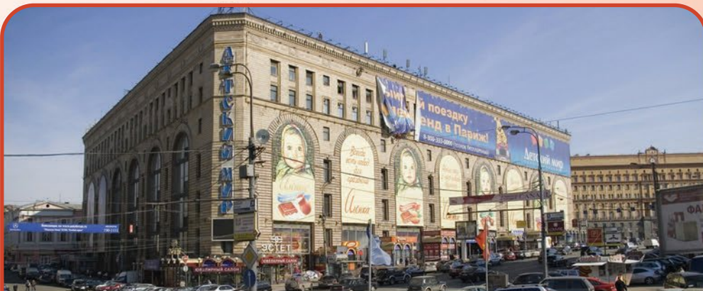
Устройство кровли Детского мира, г. Москва, 7200 м 2 , 2014 г.
