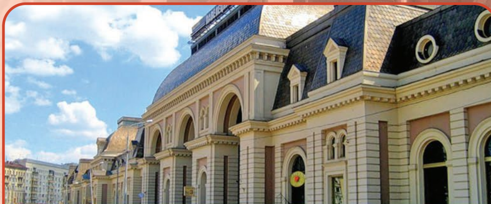
Реконструкция кровли здания Павелецкого вокзала площадью 10 500 м 2 с применением гидроизоляционного материала Техноэласт, 2013 г.
