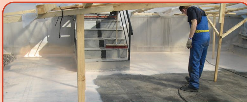
Ремонт инверсионной кровли, гостиница «Ritz Karlton» , г. Москва, 1 200 м 2 , 2009 г.
