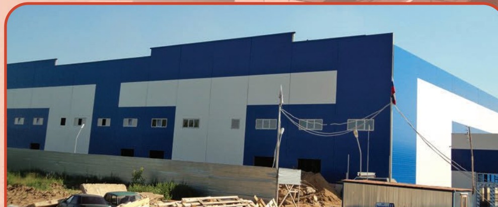
Складской Комплекс. Устройство кровли с применением ПВХ-мембраны Фатрафол-810, МО, г. Климовск, 10 500 м 2 , 2014 г.
