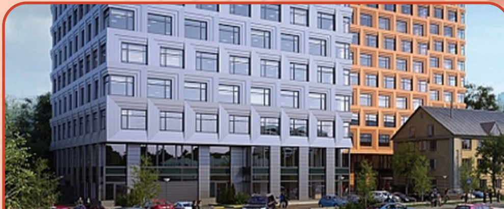
Устройство кровли Бизнес-центр «Danilov Plaza», 2570 м 2 , 2014 г.
