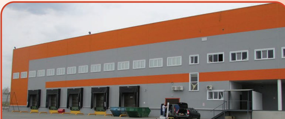
Комплексный монтаж кровли с применением ПВХ мембраны на зданиях 5 и 6 очереди производственно-складского комплекса «С-Логистик», площадь 14 000 м 2 , г. Зеленоград, 2013 г.
