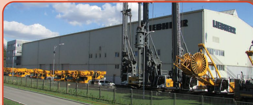
Ремонтно-складской комплекс «Либхерр», монтаж кровли ПВХ-мембраны Logicroof, 2000 м 2 , 2014 г.
