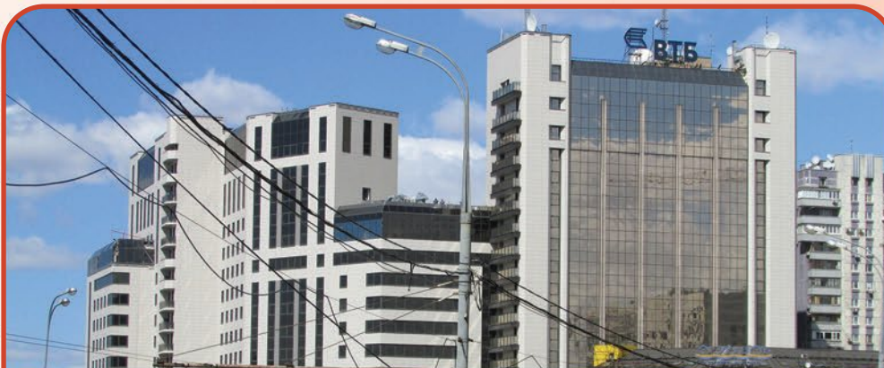
Реконструкция кровли здания «Банк ВТБ» , Перовское шоссе, площадь 3 000 м 2 . С использованием гидроизоляционного материала Техноэласт, 2013 г.
