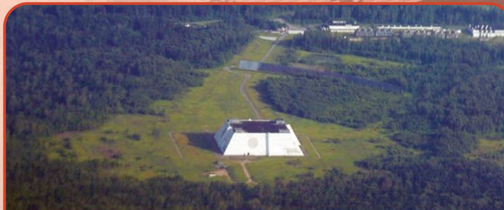
Радар Дон-2Н . Реконструкция кровли военного локатора, единственного в мире, в/ч 03523, п. Софрино-1, площадь 10 000 м 2 . С применением гидроизоляционного материала Техноэласт, 2014 г.
