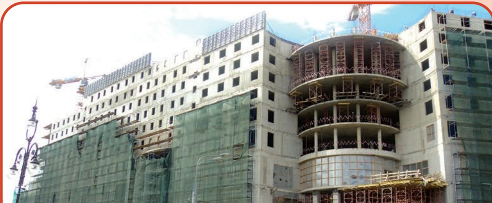
Гостиница «КИЕВСКАЯ». Устройство кровли с применением материала Техноэласт, г. Москва, 7 500 м 2 , 2014 г.
