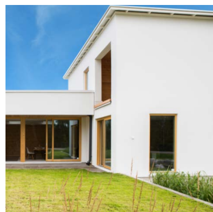
Оштукатуренная бревенчатая стена. Объект Honka Lintä на Жилищной Ярмарке в г. Хювinkя, в Финляндии, в 2013 г.
